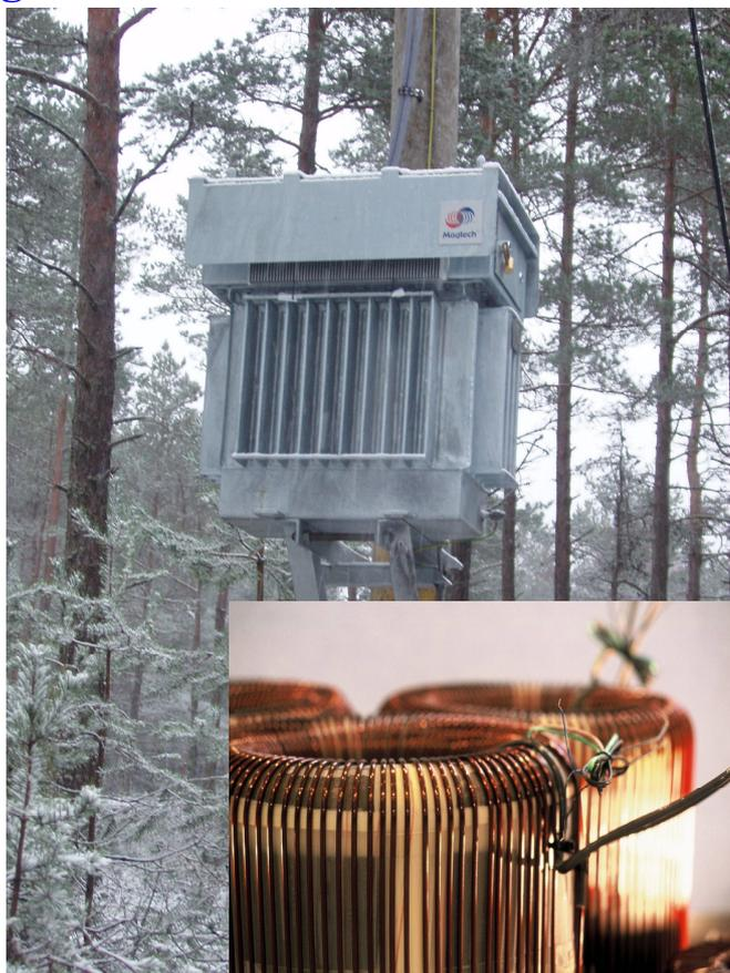
Le **MVB** est souvent la solution la moins onéreuse et la plus efficace pour pallier aux problèmes de chute de tension sur les départs, soit en permanence, soit temporairement.
